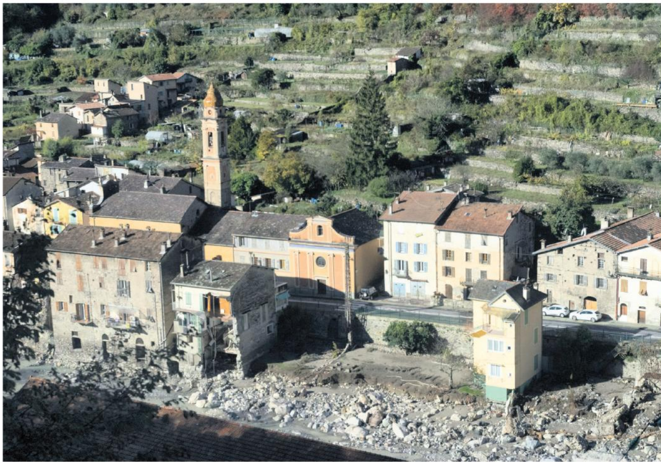
Du train, à Fontan, on aperçoit les maisons sinistrées par les crues du 2 octobre. Patricia Moribe
