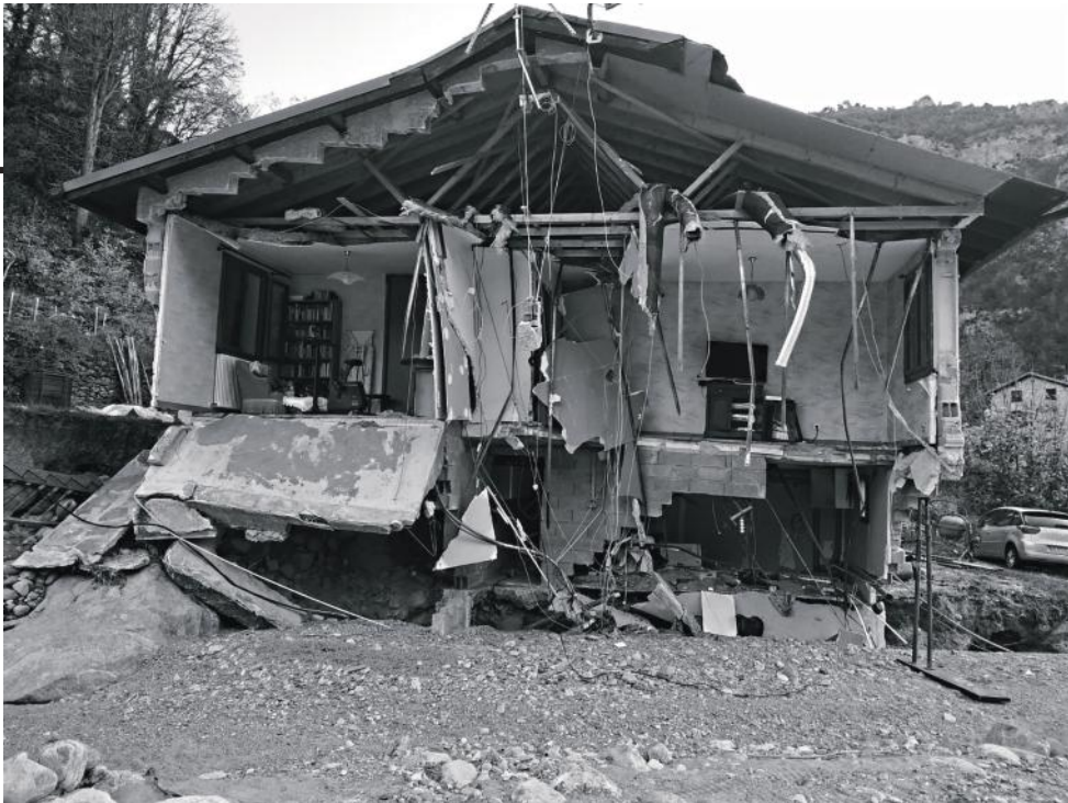
Une des nombreuses maisons éventrées en octobre à Fontant, Saint-Dalmas et Tende
