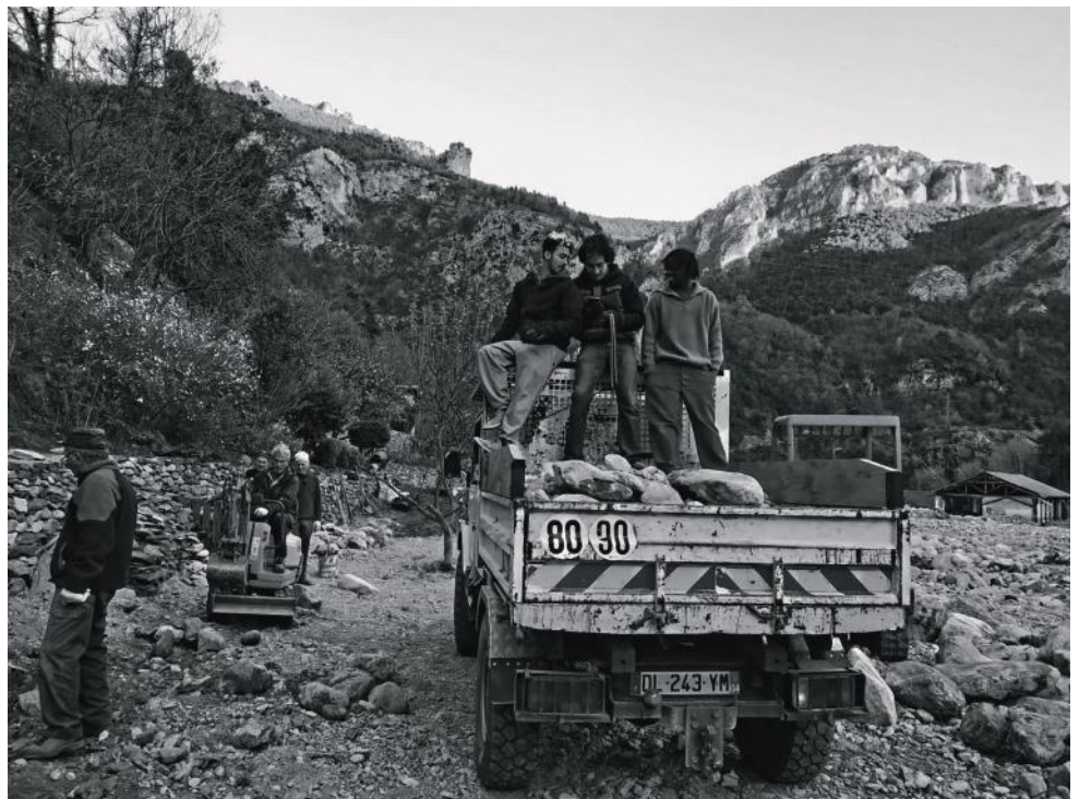
Chantier collectif pour refaire les abords d'une maison dont le jardin a été emporté par la Bieugne, affluent de la Roya
